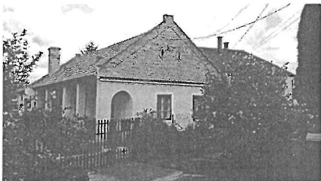
Lakóház, Kiszaludy utca 50.
