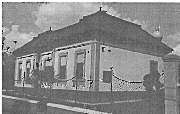
Lakóház, Fő utca 92.
